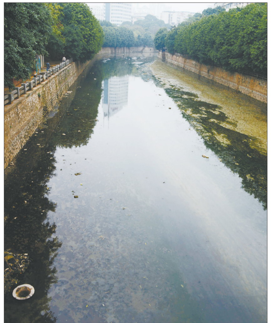
广西壮族自治区南宁市汇入邕江大河的18条内河中,17条内河水质为重度污染。除雨污合流原因外,还有人通过市政雨水管偷排污水。 中国日报网供图
