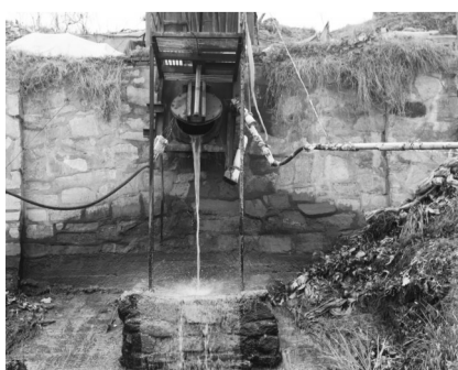
武汉段排污口:宽度约0.8米(地点:朱家河大桥,武汉造纸厂住宅区附近)
