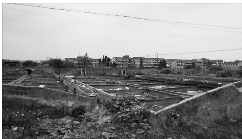
杭州市余杭区临平城东温室甲鱼棚拆除后的情景。
