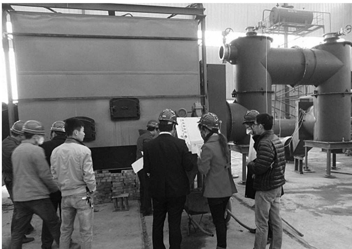
图为国内某企业生物质锅炉验收现场
