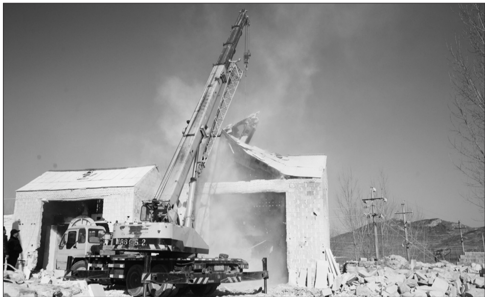
日照市深入实施十项环保重点治理工程,全力提升生态质量。图为东港区石材生产设施拆除现场。孙勇强摄
