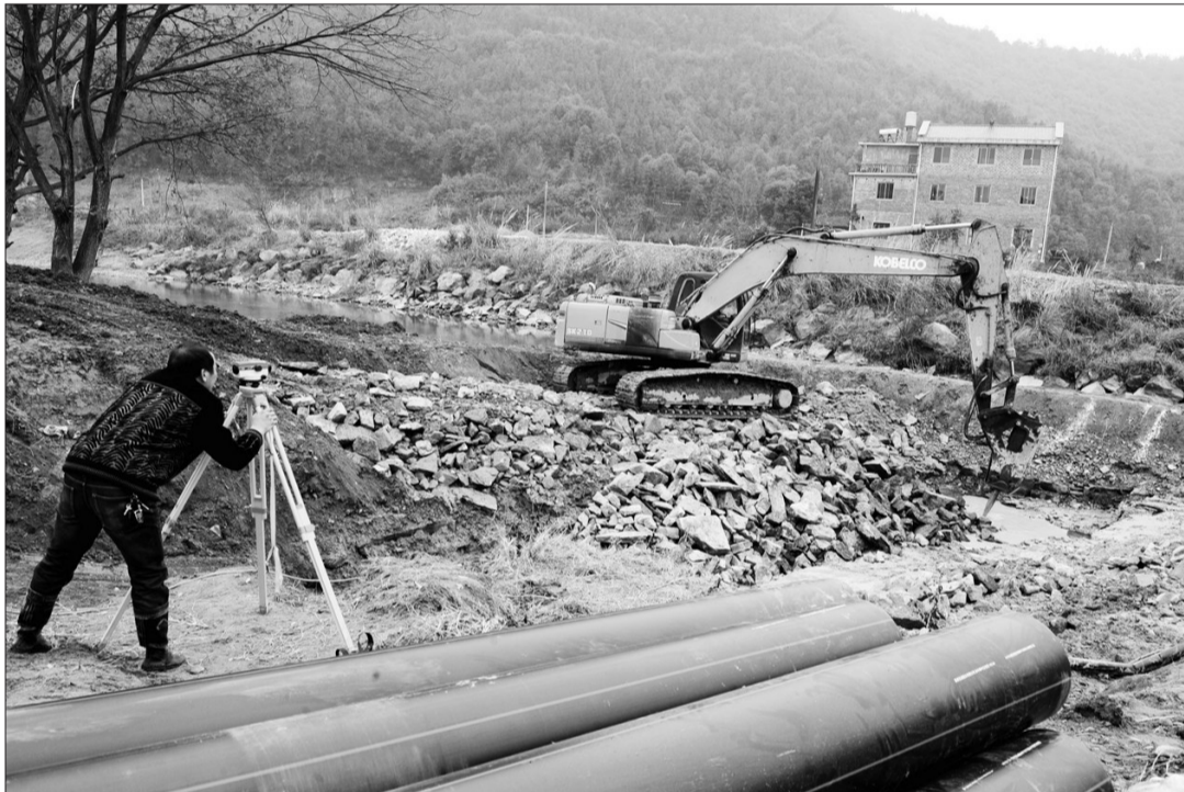
浙江省武义县小白溪河段因受沿岸工业排放废水水质污染,水质变差,媒体对此多次曝光。为彻底切断工业废水污染,武义县把工业废水截污纳管当作“五水共治”的攻坚战来打。图为施工人员在小白溪下陈工业区开挖沟渠,埋设排污管道。中国日报图片网供图
