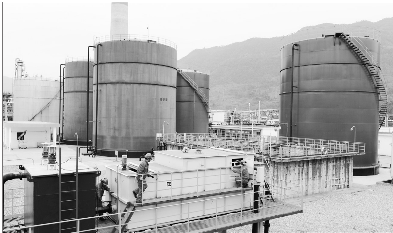
中国石化集团公司重大技改项目——普光气田天然气净化厂污水回用工程建成并投入使用,实现了污水循环利用,每年可节水255万立方米。图为工人正在做气浮机开工准备。
