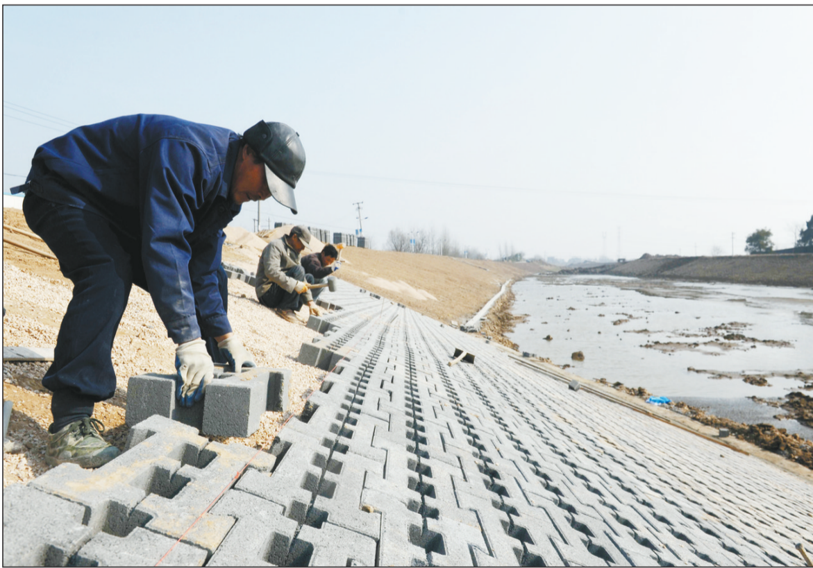
入冬以来,安徽省铜陵市冬修水利掀起高潮,主要项目有5条在建中小河流治理,两个国家现代农业示范区早涝保收标准农田示范项目水利工程,扩挖塘坝1335口,清淤沟河95条。图为施工人员在钟仓河道治理工程现场建造穿堤涵洞。
