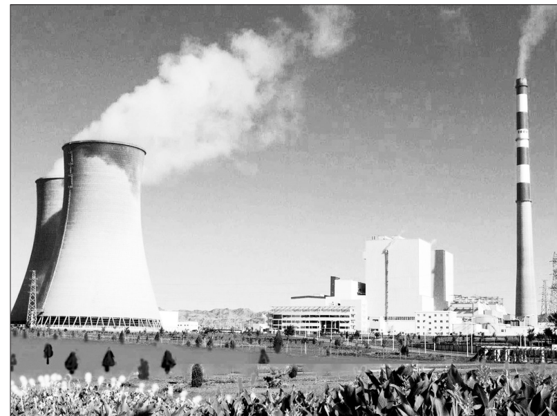
宁夏强化电厂脱硫工程建设,使全区火电机组脱硫设施建设处于全国前列。 张伟摄
