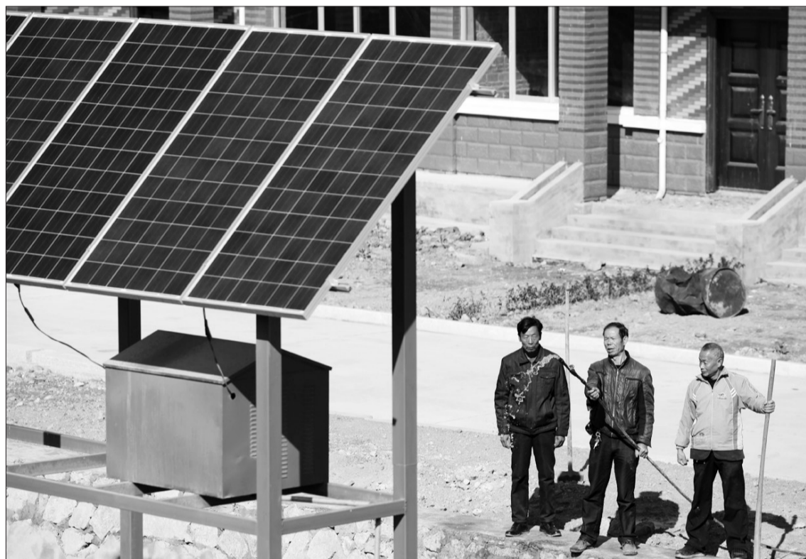
福建省莆田市许多农村引进太阳能微动力污水处理系统,利用太阳能光伏发电提供电力来源,让农村生活污水经过处理后,实现水质达标排放,解决长期困扰农村的生活污水排放问题。 人民图片网供图
