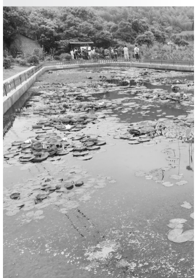
浙江省宁波镇海区九龙湖上游积极治理农村和“农家乐”污染,图为农村生活污水经处理后进入人工湿地深度处理。 晏利扬摄
