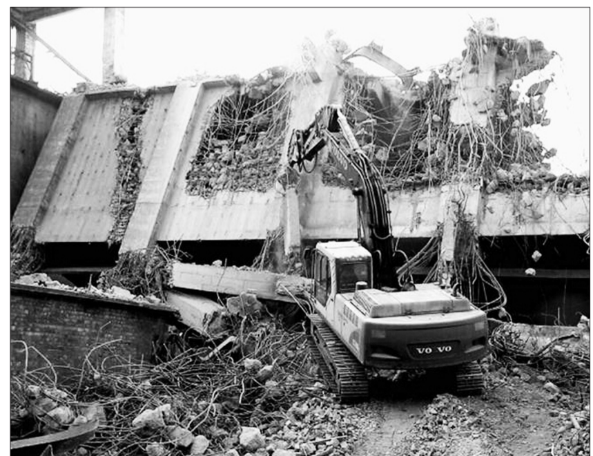
包头钢铁(集团)有限责任公司加大淘汰落后产能力度,推进节能减排,去年投入23亿元,实施脱硫除尘等环境治理工程71项,污染防治和节能减排工作取得重大进展。图为近日施工车正在拆除炼铁厂淘汰的最后一座竖炉。李俊伟 刘清成摄
