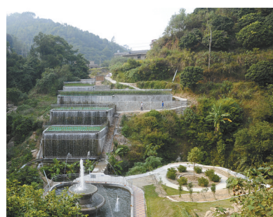
位于玉林市玉州区大塘镇大双村的农村污水处理设施依山而建。
