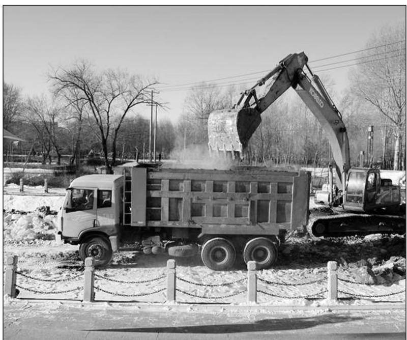
内蒙古自治区阿荣旗那吉镇日前抓住冬季河道冰封期时机,组织4支专业清淤队展开为期两个月的河道清理工作。图为河道清理现场。
