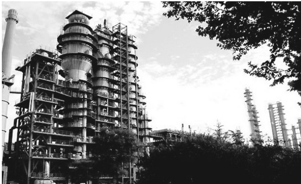
中石化石家庄炼化截至目前已安装了4万多台计量仪器,实现能源计量数据的在线采集和实时监控。
