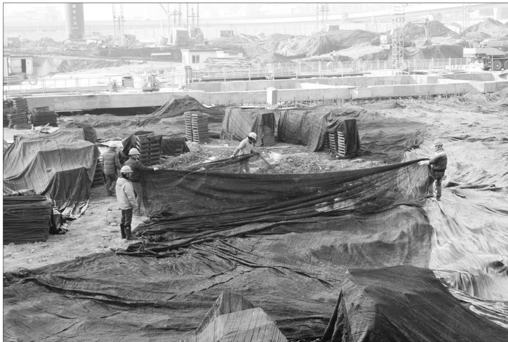
为确保第四季度PM<sub>2.5</sub>平均浓度控制在80微克/立方米以内,南京市出台了6条严格控霾举措。图为工人对一家建筑场地露天土方进行覆盖。 褚方樵摄
