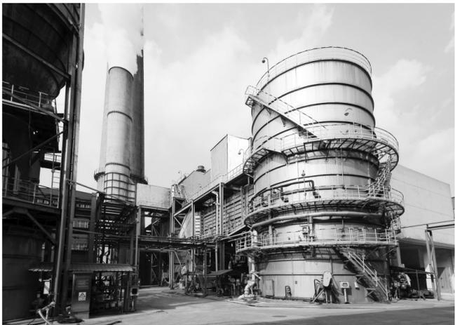
虽然通过采取减排措施,南京市二氧化硫、二氧化氮等污染物明显削减,但其他污染物排放仍居高不下。图为南京梅山钢铁厂上马的脱硫装置。 褚方樵摄
