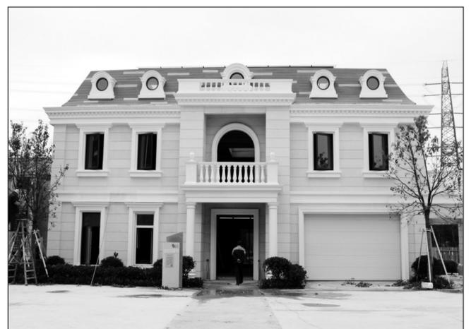
5幢使用3D打印技术建造的建筑近日亮相江苏省苏州工业园区。这些建筑的墙体由大型3D打印机层层叠叠加喷绘而成,打印使用的“油墨”则由建筑垃圾、水泥、砂浆和特制凝固剂等制成。据介绍,这种3D打印的墙体牢固强度是传统建筑承重墙的5倍,建筑工期可缩短70%,建筑成本可至少节省50%以上。 中国日报图片网供图
