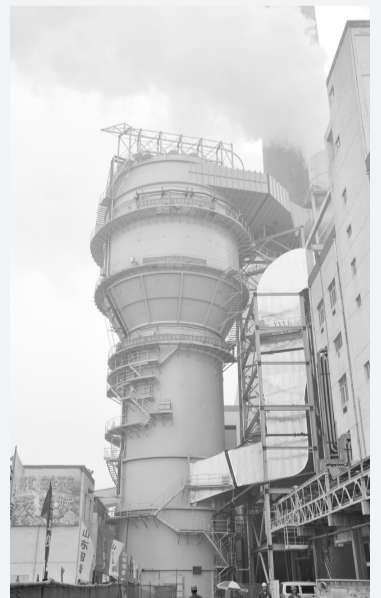
图为白杨河电厂建设的6#机组二级脱硫吸收塔和湿式静电除尘器一体化结构,在全省率先实现燃煤机组超低排放。
