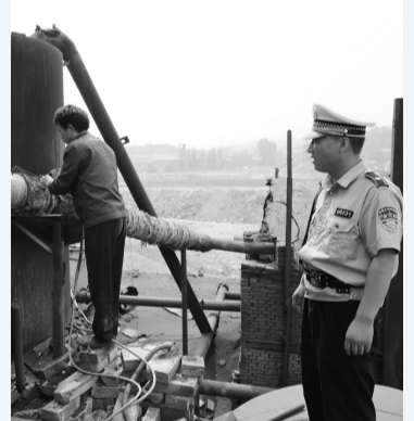
图为—跨界小炼铁厂被依法取缔。
