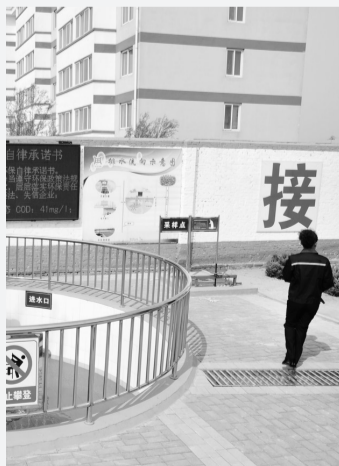
图为德州泰鼎新材料科技有限公司设置在厂外的污水排放口和生物指示池。
