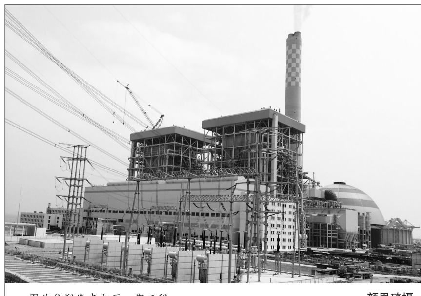
图为华润海丰电厂一期工程
