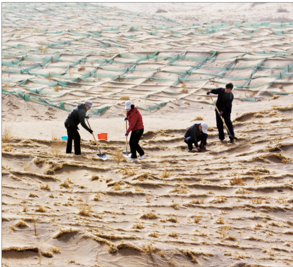
甘肃省临泽县位于巴丹吉林沙漠边缘,生态环境极其脆弱。多年来,当地采用压芦草、土工布、组沙网、种红柳等方式治沙固沙。目前,已建成防风固沙林27.1万亩。 人民图片网供图
