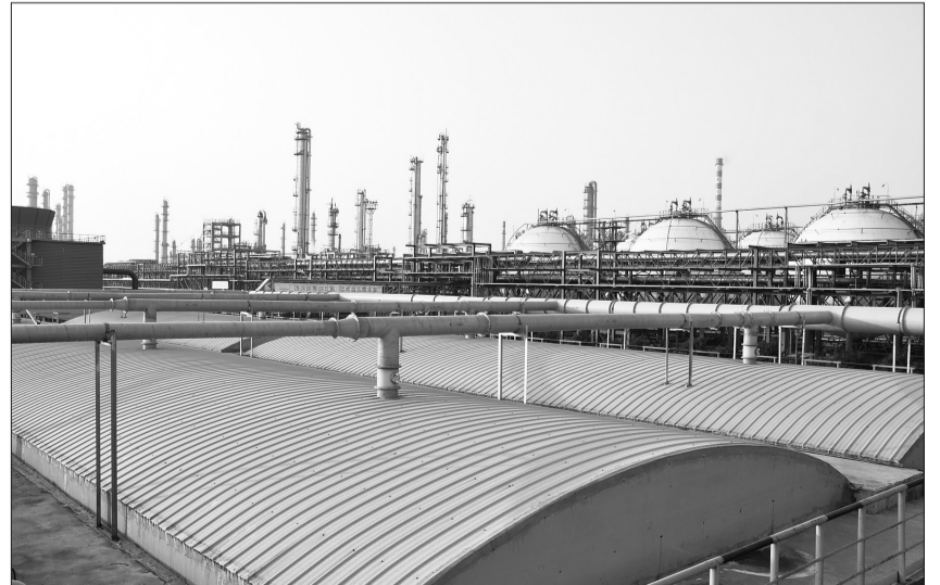
针对工业异味污染问题,山东省菏泽市积极督促企业投入资金3.2亿元,建设了一大批先进的挥发性有机废气收集处理设施,异味污染信访投诉明显降低。图为玉皇化工有限公司对厂区污水处理设施全部进行密封、回收净化处理,有效减轻了异味气体对周边居民的影响。
