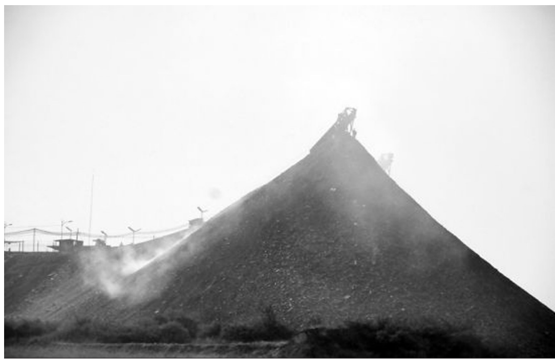
图为霍州煤电集团辛置煤矿
