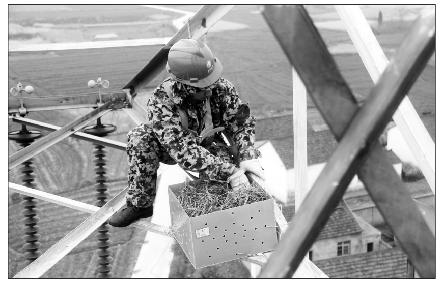
春暖花开,各种鸟类易在电力线路杆塔上筑巢,鸟巢悬挂物对电力线路安全稳定运行造成了一定威胁。安徽省芜湖供电公司自今年起尝试在各电力线路上安装特制的人工鸟巢“引鸟篮”,“引鸟篮”的安装,既可消除电力输电线路安全隐患,又不影响户外鸟类的自然生活,实现了人鸟和谐。 中国日报图片网供图
