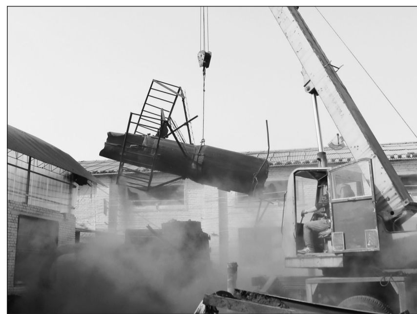
河北沧州泊头市是我国三大铸造基地之一,耗能高、污染重是铸造产业突出的问题。在去年治理的基础上,泊头市今年决定用3~5个月的时间,再度对700多家铸造企业进行深度治理。目前,已有144家企业完成整治并重新开工,关停企业97家。图为工作人员拆除落后设备。 人民图片网供图
