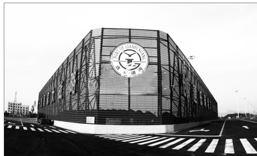
一道高达15米、绵延数百米的绿色屏障日前出现在江苏省连云港市港口59号泊位的煤炭堆场。这是连云港市为彻底治理码头粉尘污染而建设的防风抑尘网试验工程。
