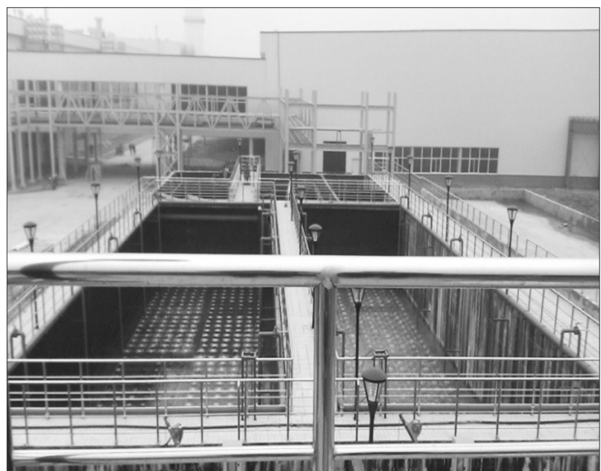
图为江铃汽车有限公司污水处理站。
