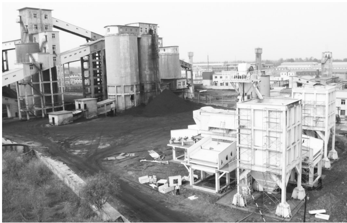
经研究,新型空气重介干法选煤系统把选煤主机流化床面积扩大为54立方米,是传统空气重介干法选煤系统的13倍。从而,处理能力也由原来的50吨/小时提高到500吨/小时,为空气重介干法选煤技术大型工业化奠定了基础。
