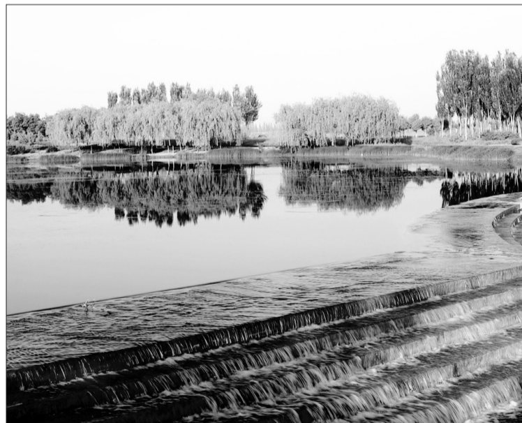
昔日臭水沟,今朝景观道。银川市永二干沟污染治理效果明显。
