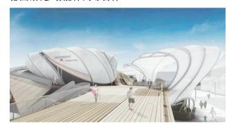
德国馆建筑名为"灵感的田野"。入口的坡道通往建筑的空 中平台,坡道采用各种色调的木材平铺。西南角的"德国广场"提 供了一个聚集、表演、活动的场所。建筑首层的斜向阶梯座位与 餐厅能容纳350人。而主屋顶以白色弧形拉伸织物建构,可以遮 阳,还连接了室内外空间。整个场馆像是一个休闲综合体。
