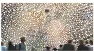
英国馆这次的主题是蜜蜂种群的危机。整座场馆主要分 为露天花园和模拟"蜂巢"的巨大圆球形装置,其中"蜂巢"这 一球形结构是核心,整体采用大量细钢格栅和LED灯组成, 密集相连的钢结构犹如蜂巢,呈矩形,高3米,中心是一个椭 圆形的空间,游客会在内部感受蜂巢的模拟实景。而前方以 大量植物、果树覆盖的花园也与蜜蜂的移动轨迹密切相关。
