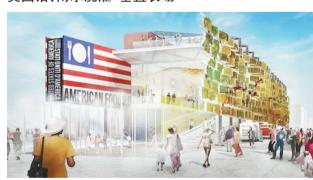
与欧洲众场馆相比,美国馆走的路线少了份精致,多了份粗 犷。展馆以"食物"为主题,最明显的是建筑物外部层叠的农作物 ——仿佛一个垂直农场,这些作物将以雨水系统进行浇水。场馆 入口处的通道采用循环回收的美国常见的木板路木材制成,一直 延伸到二楼。此外,建筑外部大量使用光伏电池板为场馆供能。
