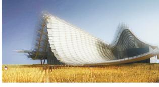
中国国家馆总面积4590平米,是这次世博会第二大规模 的场馆。中国馆主题为"希望的田野,生命的源泉",场馆建筑 外形起伏蜿蜒,灵感源自田野上的麦浪,屋顶则采用竹编材 质,通过传统竹编工艺选择不同的透光率,将自然采光引入室 内,降低人工照明的能耗。场馆周围以及内部广场以一根根 LED枝干装置覆盖,模拟稻田,形态逼真。
