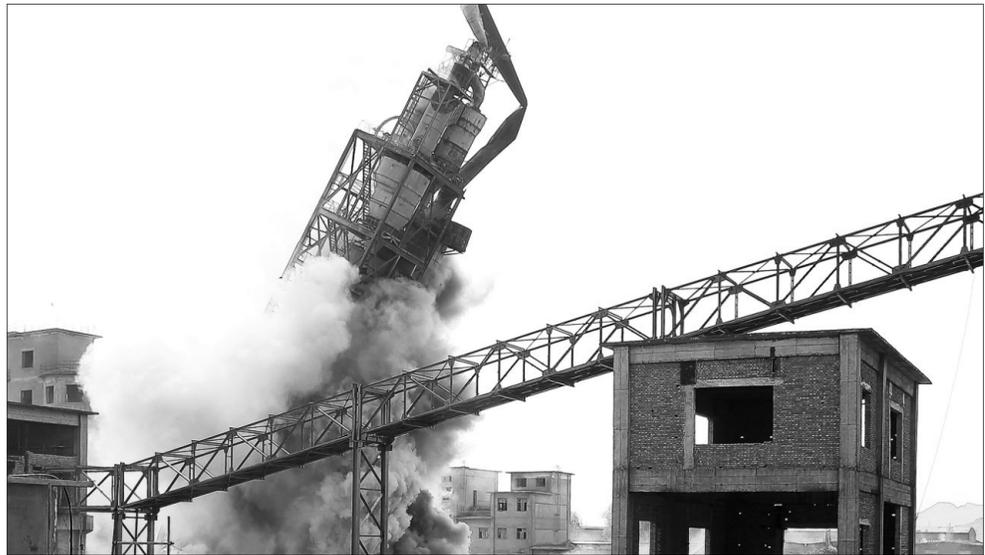
自河北敬业集团重组乌兰浩特钢铁有限责任公司以来,乌钢加快推进环保设施升级改造,所有改造工程将于今年6月30日前完成。图为乌钢原水泥厂的五级旋风预热器及筒形钢塔正在拆除,标志着乌钢淘汰落后产能提升环保项目的最后一批爆破工程圆满结束。
