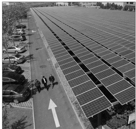
由阳光电源开发建设的安徽合力太阳能光伏停车场日前正式并网发电。这个停车场总装机容量为863.5千瓦,是目前安徽省最大的户外停车场光伏应用项目。据悉,光伏停车场一次可停放300余辆小汽车,不仅能够为车辆遮阳挡雨,还可为日益普及的电动汽车提供就近充电服务,极具实用性。
