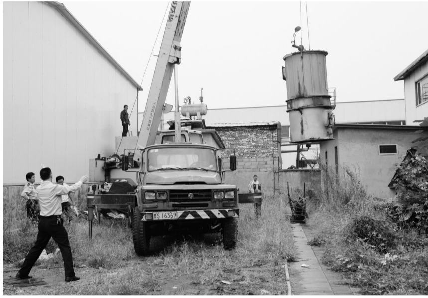
因为环境执法人员在拆除工业燃煤锅炉。
