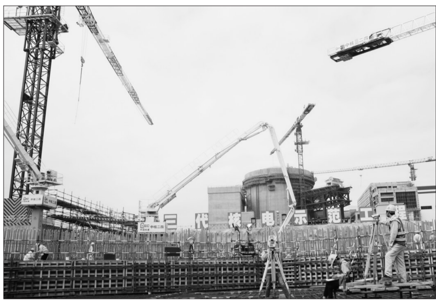
图为工作人员在“华龙一号”开工现场进行施工测量。
