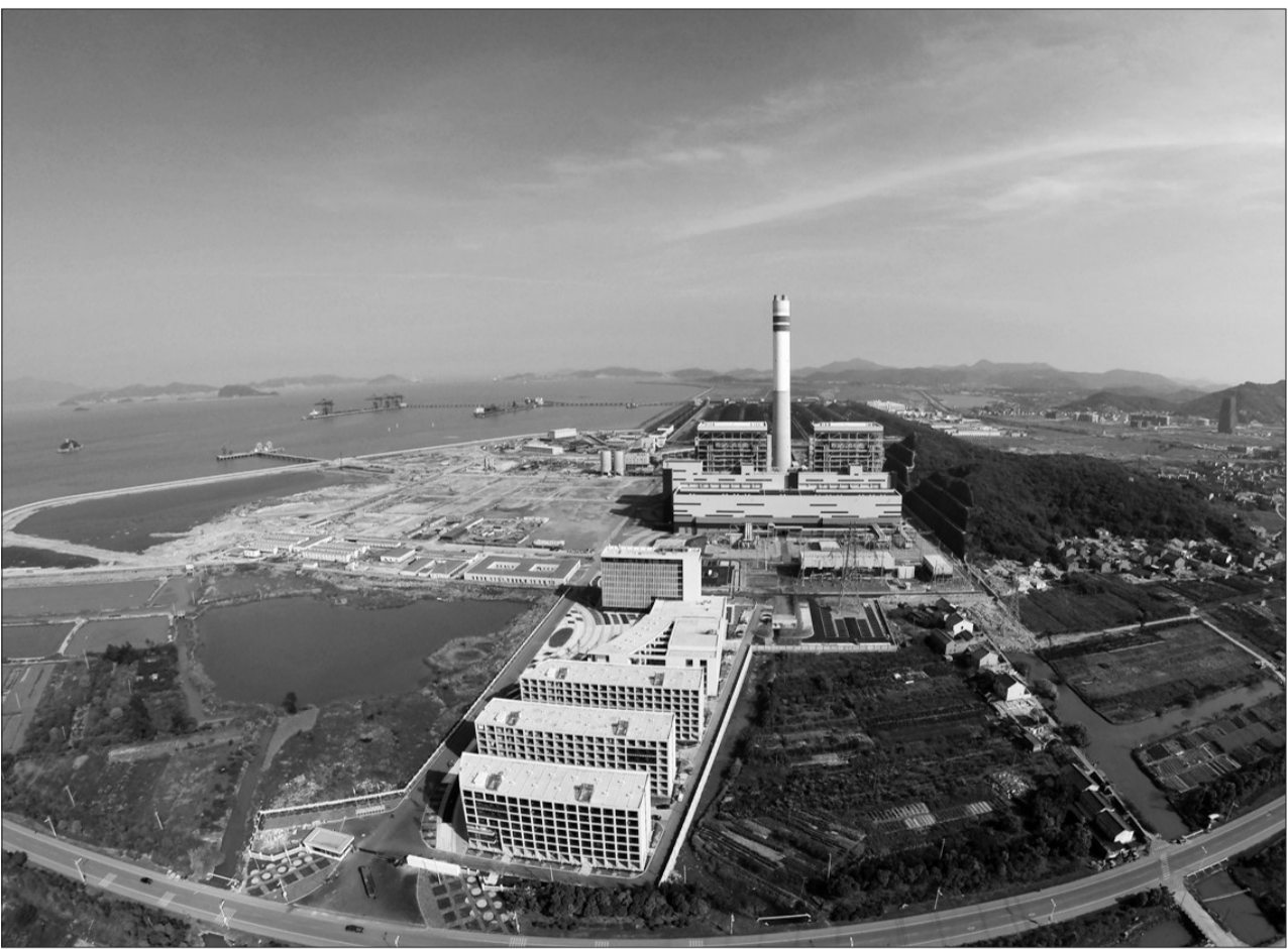
作为浙江省舟山群岛新区重大基础设施项目的浙能六横电厂,近日通过舟山市环境监控中心验收。今后,浙能六横电厂的烟气排放数据可通过舟山市及普陀区环保局网站在线查询。 中国新闻图片网供图
