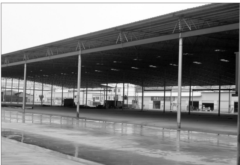
佛山市南海区朗下村将曾经的村级工业区改造成现代物流基地。 欧核供图
