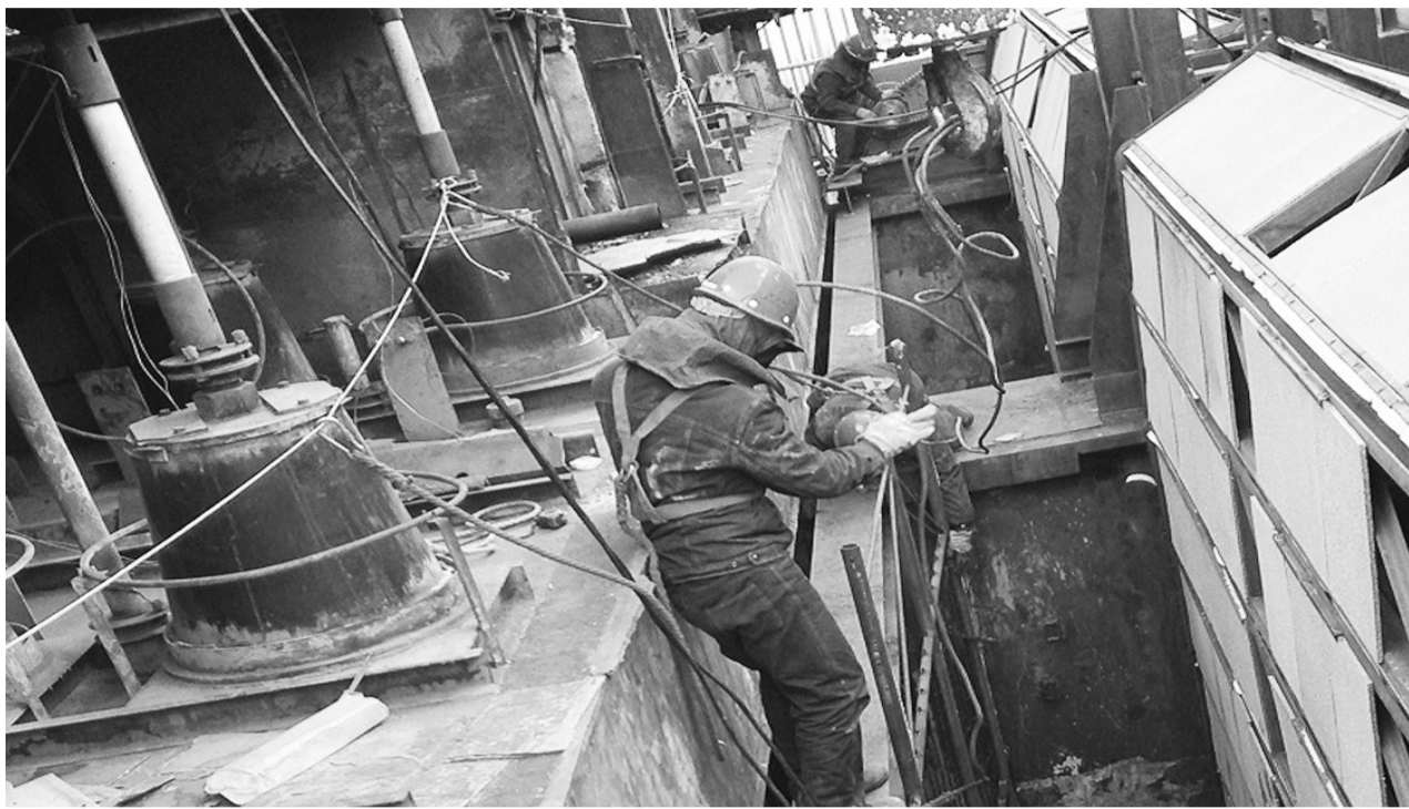
图为中电投清河发电公司8号机组烟气除尘改造现场。
