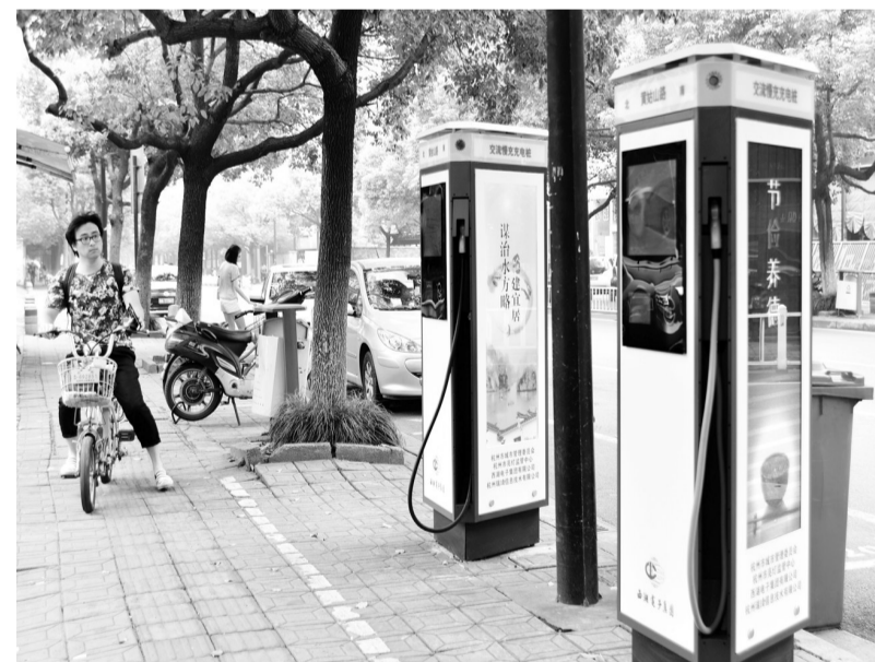
浙江省杭州市城管委近日在黄姑山路开展了综合智能路灯杆试点项目。据介绍, 智能路灯杆不仅可供市民免费无线上网, 而且能给电动汽车充电, 电子显示屏可以搜索出周边哪里有停车位, 还可以作为视频监控设施。 人民图片网供图
