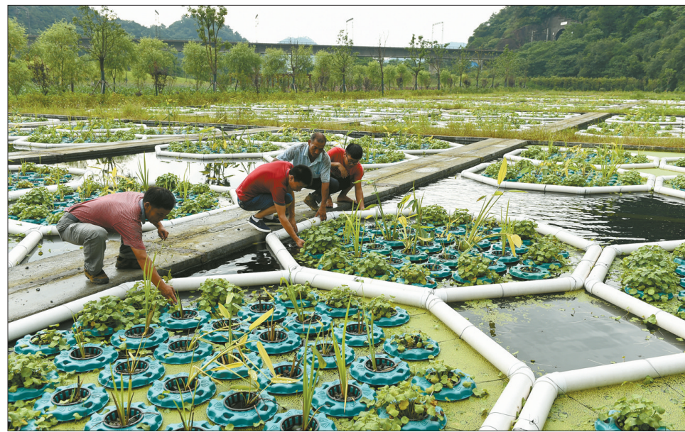
浙江省义乌市所建的生态湿地大多采用微污染水生态系统净化的工程手段,充分利用太阳能和自由水面,建立高效净化物理—植物生态系统。大陈湿地公园自今年6月投入使用以来,每天可处理污水处理厂的尾水两万吨,尾水中氨、氮、磷指标明显下降。 人民图片网供图
