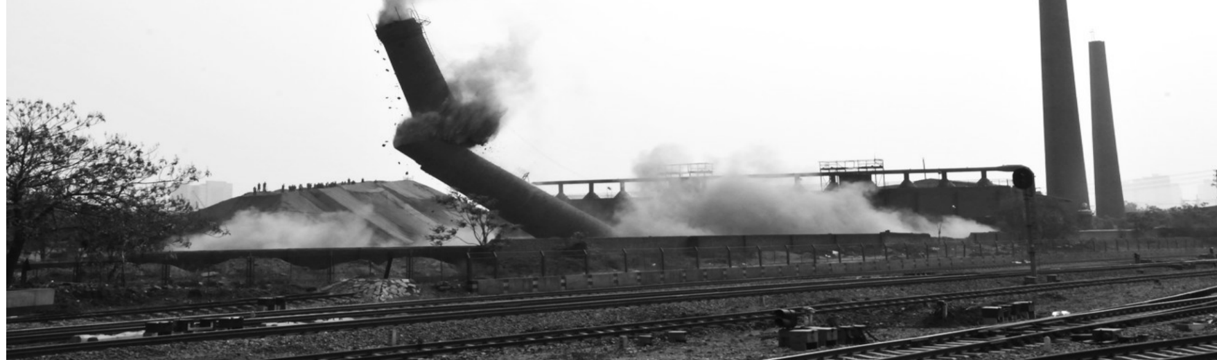
图为河北省废弃烟囱集中拆除行动中烟囱倒下瞬间。
