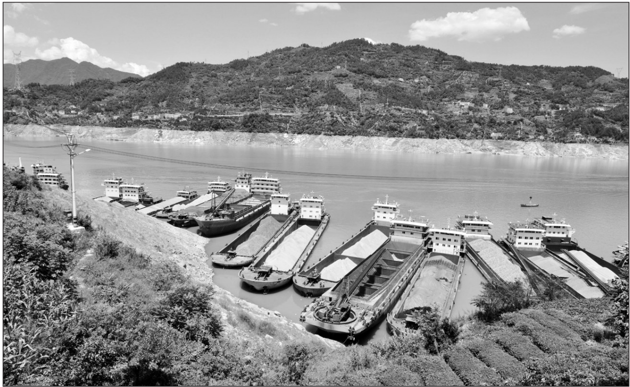
三峡库区湖北省秭归县沙湾锚地待闸船舶近日用上了岸上供电。据了解,在船舶靠岸期间,采用陆地电源供电,既能减少燃油发电的成本费用,也可减少对水和空气的污染。人民图片网供图
