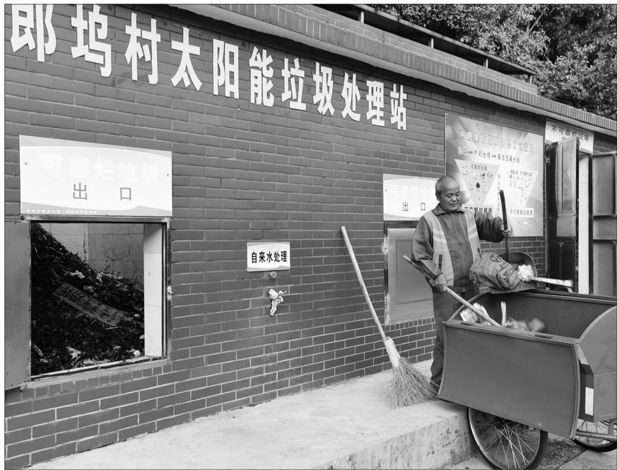
在浙江省义乌市大陈镇郎坞村太阳能垃圾处理站,环卫工人在处理农村生活垃圾。目前,大陈镇有11个村庄都建立了这样的太阳能垃圾处理站。太阳能垃圾处理原理就是利用太阳能和微生物,太阳光照射到垃圾处理站上面的透明玻璃,集聚热量,加速垃圾的腐烂过程。 人民图片网供图
