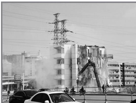
郑州某城中村拆迁现场,拆迁过程中产生大量粉尘,拆迁后建筑垃圾未覆盖防尘网,易起灰尘,造成的粉尘污染十分严重。
