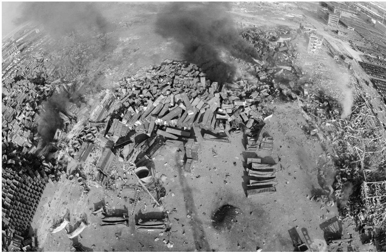
图为航拍天津港爆炸事故现场。
