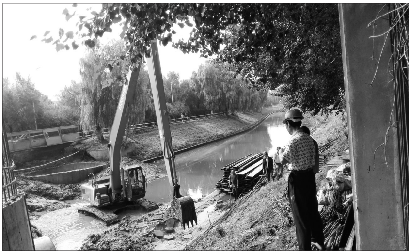
图为马家沟清淤疏浚现场。
