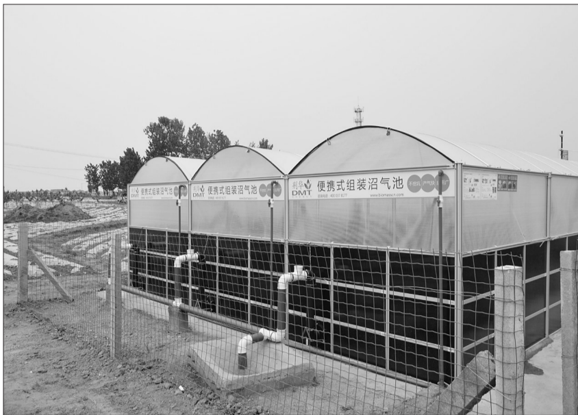
图为山东省莒县洛河镇陈岭村就宝香养殖场建设的3组便携式组装机沼气池。
