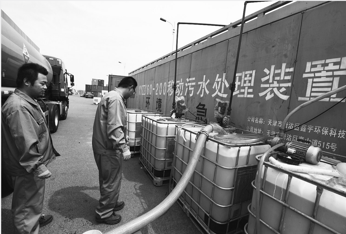
图为天津鑫宇环保科技有限公司在事故现场安装了第一套破氨装置,对爆炸核心区污水进行应急处理。
