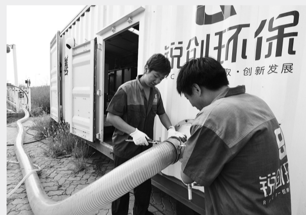
图为天津锐创环保公司安装的爆炸核心区污水应急处理第二套破氨装置。
