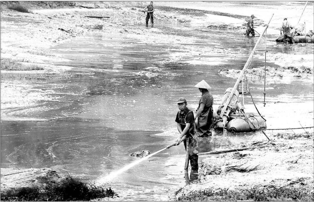
浙江省台州市椒江区近年来定期对辖区河道进行清理疏通,保持河道整洁和水体清澈。图为在葭芷泾断水后的河床上,工人们正在冲刷河床沉积的污泥,然后用吸泥泵吸运淤泥。 人民图片网供图
