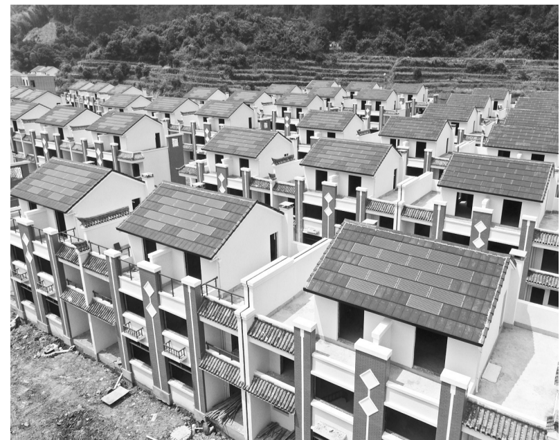
用光伏陶瓷瓦替代传统瓦片来发电,宁波鄞州龙观乡李畲村将建成全国规模最大的光伏村。这个村344户新居民住宅等屋顶上安装500千瓦分布式光伏电站,年发电量将达50万千瓦时。
