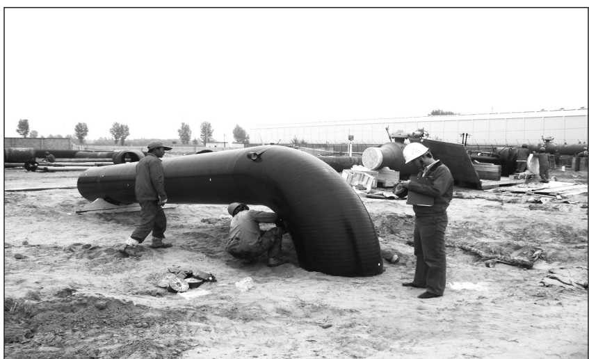
图为环境监理工作人员对管道防腐工作进行巡视。
