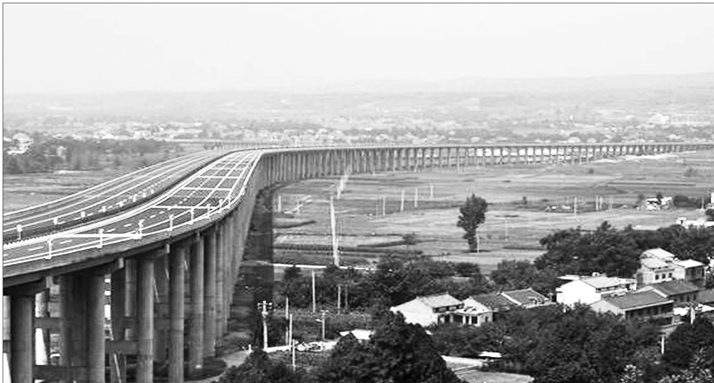
图为博厚建设环保工程有限公司监理国家高速公路上海至西安线(G40)陕西境西安至蓝田至商州公路段(陕西省交通建设集团公司西商高速公路建设管理处)的项目工作。
