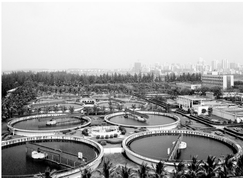
海口市白沙门污水处理厂不断扩容升级,通过生产工艺调整,降低出水COD、氨氮等污染物指标,更大程度减少污染物排放量。本报记者孙秀英摄
